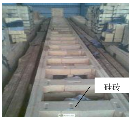
图1 采用高导热硅砖的焦炉炭化室
